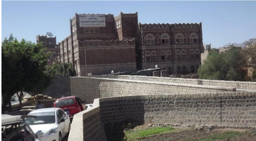
شكل (2): مدرسة الطبري إحدى المدارس التي أقيمت على أرض مستقطعة من بستان المدينة القديمة (بستان شوشة)، الصورة للمدرسة بعد إعادة بنائه على الطراز الصناعي، (الباحث).
